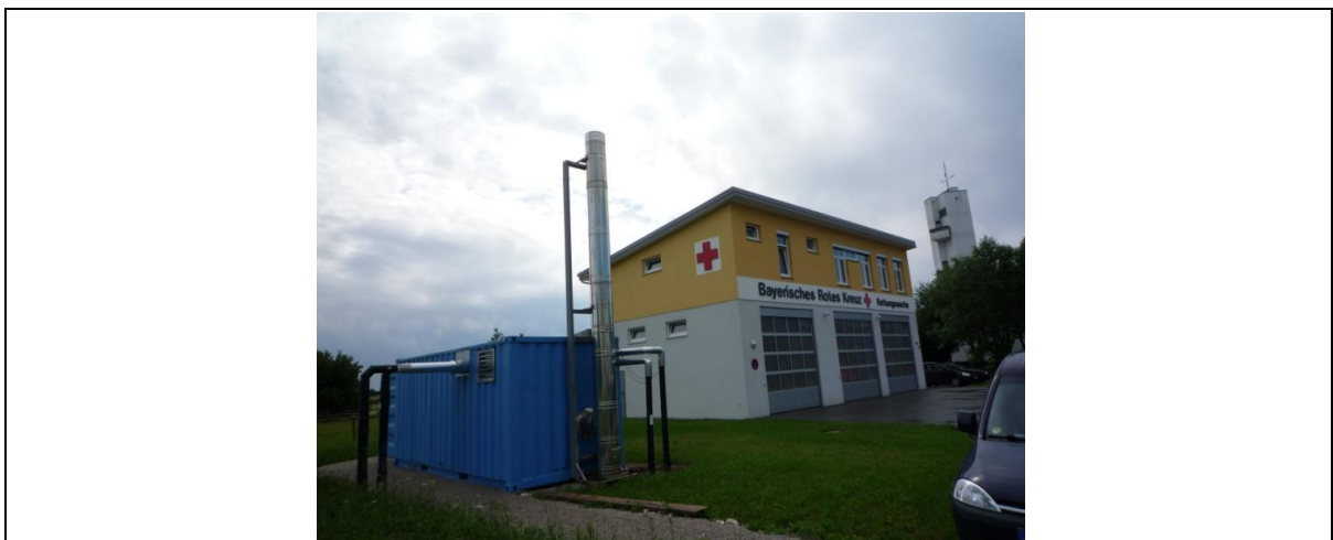
Abbildung 22 Provisorium mit Heizölkessel zur Versorgung des BRK und des Altenstifts an der Augsburger Straße „kleines Provisorium“
